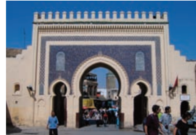
Puerta de entrada a la antigua medina de Fez Gateway to the old medina of Fez
